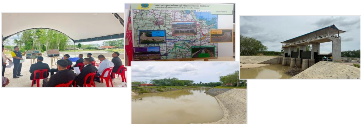
ก.ธ.จ. สงขลา ประชุมและลงพื้นที่สอดส่องโครงการประตูปรับน้ำคลองภูมิ พร้อมอาคารประกอบ ตำบลรัตนภูมิ อำเภอควนเนียง จังหวัดสงขลา
